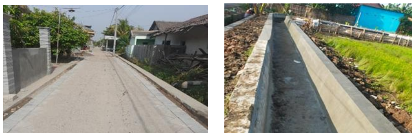
Gambar 3. Kondisi Jalan Pavingisasi dan Pembangunan Saluran Irigasi
