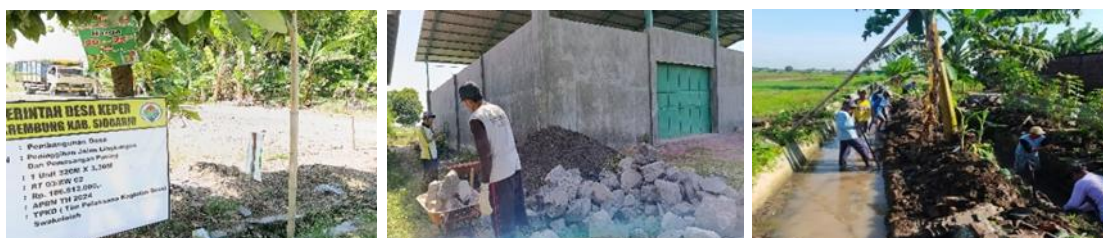
Gambar 2. Pembangunan Jalan Paving, Gedung Serbaguna dan Pembuatan Saluran Irigasi
