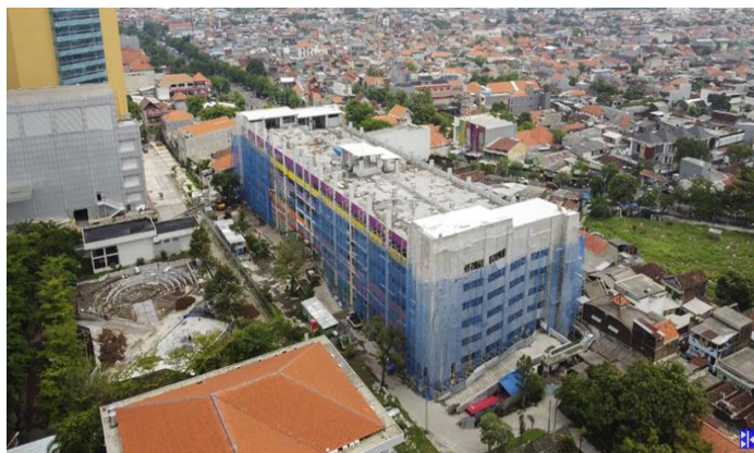
Gambar 1. Gedung Parkir Universitas Airlangga Kampus B (Bina Karya Surabaya)
